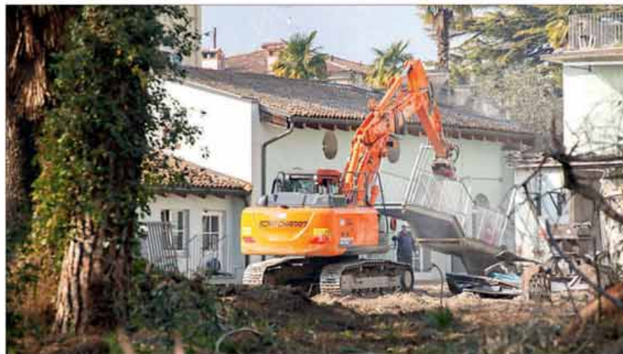
Un'altra immagine dei lavori di demolizione iniziati ieri (Foto Shop Professional)
